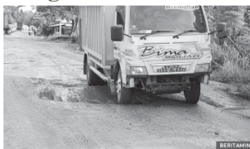
PARAH- Kondisi jalan lintas lama yang menghubungkan kabupaten Dharmasraya, Sumatera Barat, dengan Kabupaten Tebo Jambi, cukup parah dan banyak yang berlobang ketika musim hujan, kondisi jalan yang berlobang tergenang air dan becek (foto: Ist/net).
